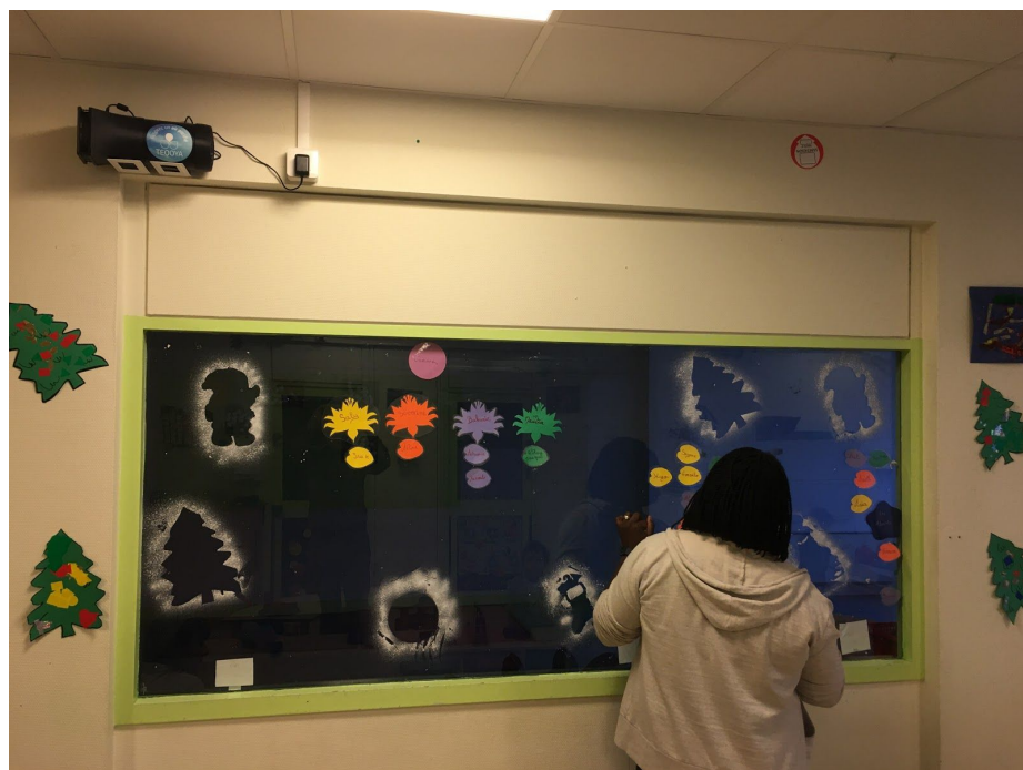
Purificateur d'air CYCLO tel qu'installé sur la cloison Est de la salle LOTUS
